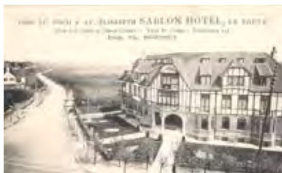
Fochlaan - Elizabetlaan, het 'Sablon Hotel' van de familie Rombout uit 1922, omgevormd in de jaren '50 tot appartementen maar met behoud van het bouwvolume.
